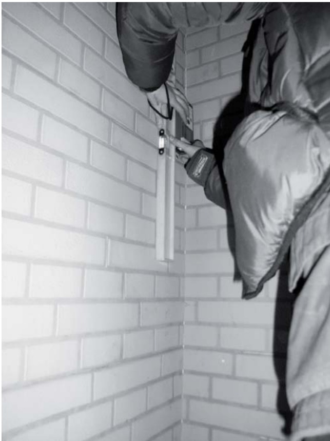
Vertikal måling med lasermåler og vater.
