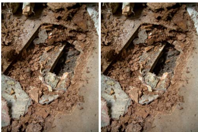
Eksisterende kjellergulv i Thingvallagårdens hovedbygning.
