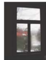
3. Vindu mot øst.
