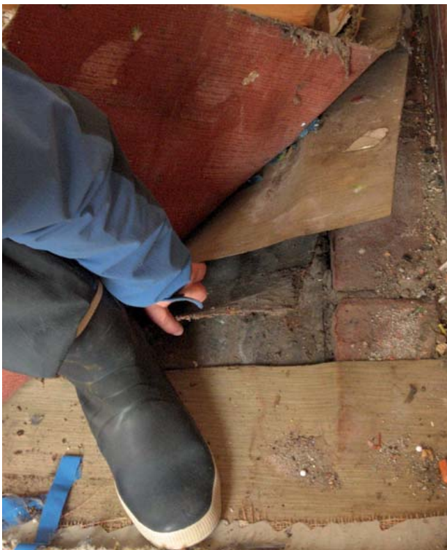
Enkelte steder var overflatene løse nok til at vi kunne undersøke hva som var under.
