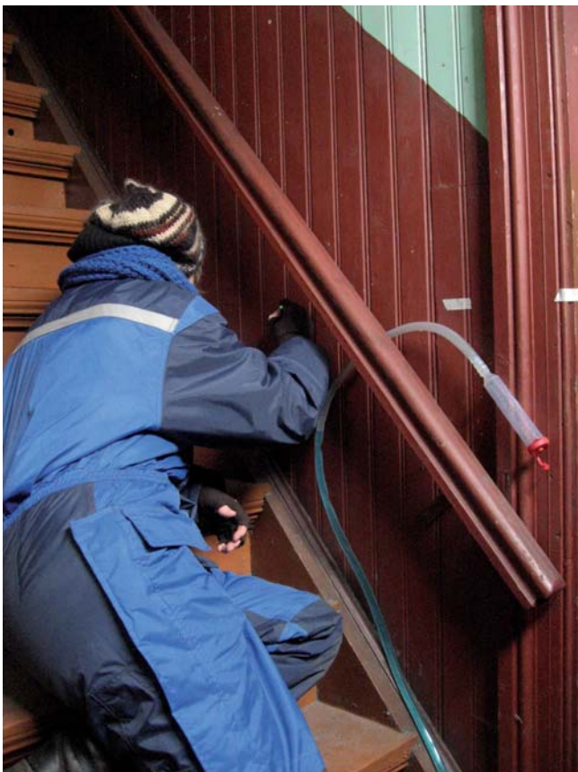
Avmerking av nytt horisontalnivå over trapp.
