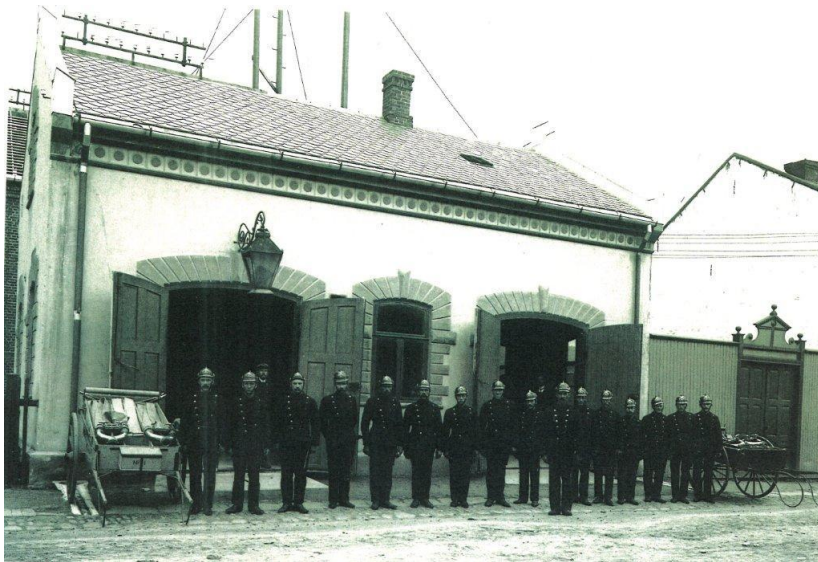
Eldre fotografi som viser den første brannstasjonen på eiendommen
