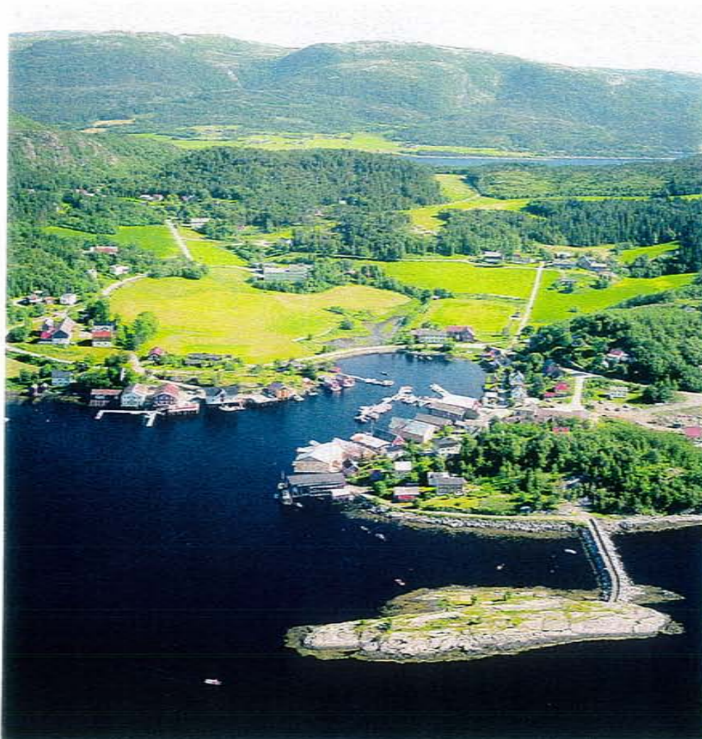
Bilde 42 . Vågen og havna sett fra sør. Begge bildene viser tydelig at flytebryggene ligger for langt ut i Vågen.
